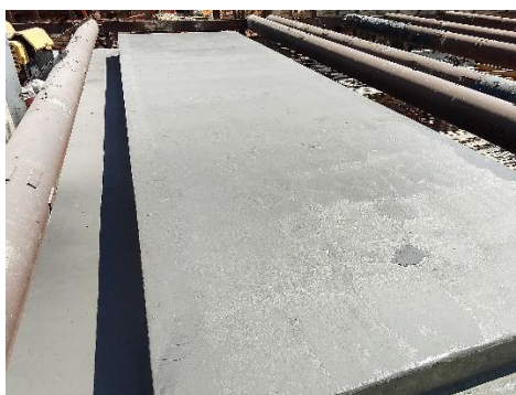
Фото 1 — Полимочевинное покрытие «Химтраст ПМ Премиум» на бетонном основании
