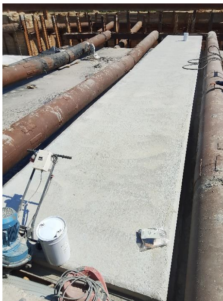
Фото 2 — Бетонное основание перед нанесением «Химтраст Праймер-ПМ (1К)»
