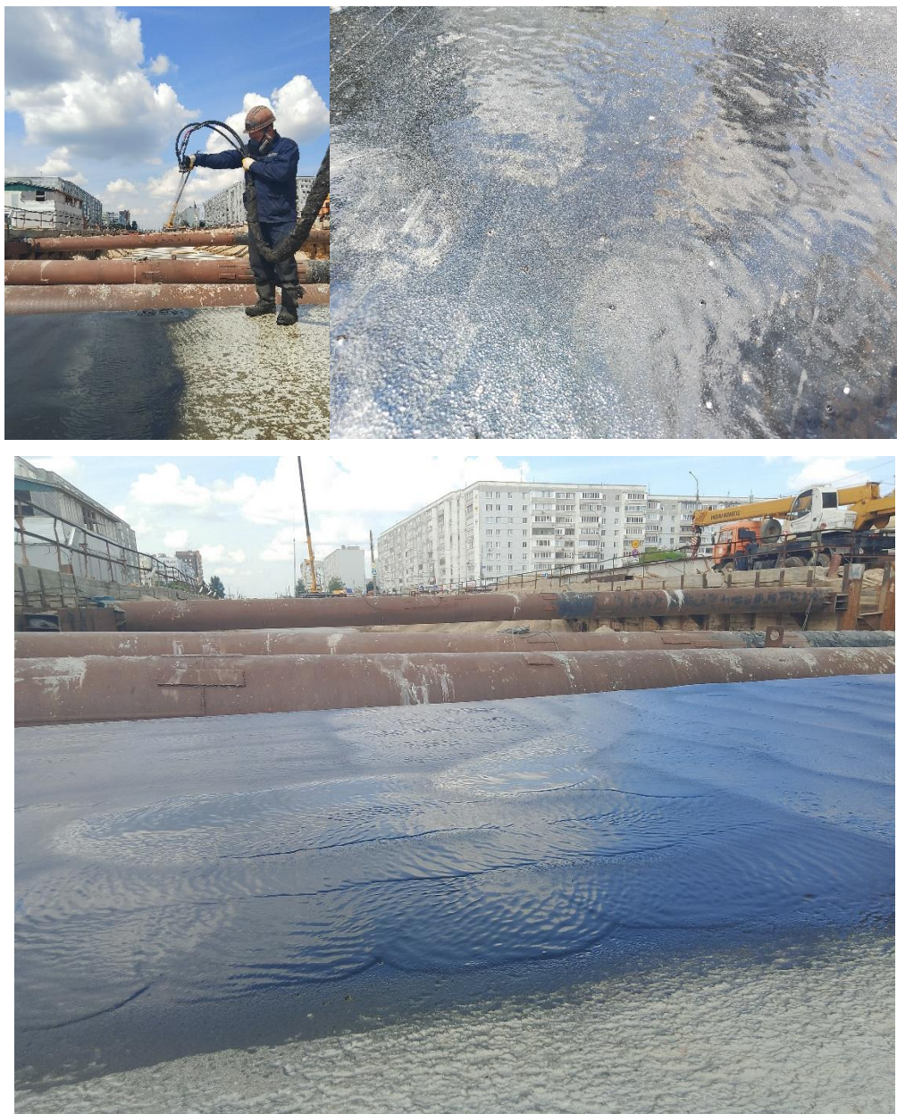
Фото 4 — Контрольное напыление полимочевинного покрытия в присутствии специалистов АО «Химтраст»
