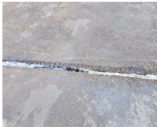
Фото 2–5 — Исходное состояние покрытия, участок с праймером и деформационный шов между бетонными плитами
