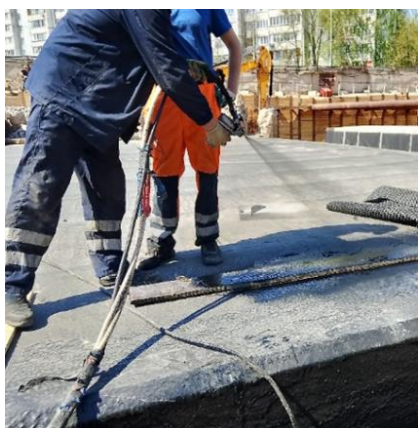
Фото 6–8 — Контрольное напыление и образцы, полученные при рабочем давлении 145 и 170 бар
